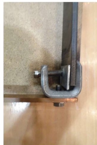
b) Anschluss der MKD-Montageklemme
