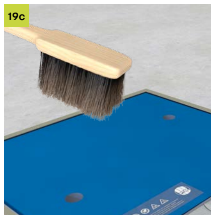
19c Darauf achten, dass die Fugen schmutzfrei sind.
