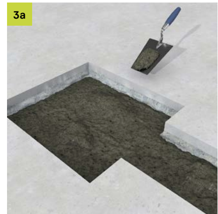
3a Gleichmäßig Ausgleichsmasse (ca. 5 mm) einstreuen, um Kanal und Kassette anschließend plan zum umgebenden Boden ausrichten zu können.
