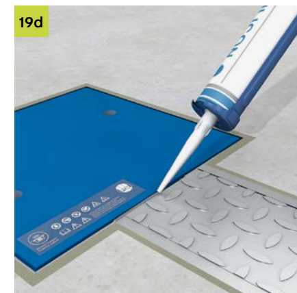
19d Dichtungsmasse zwischen Kassette und Kanaldeckel aufbringen.
