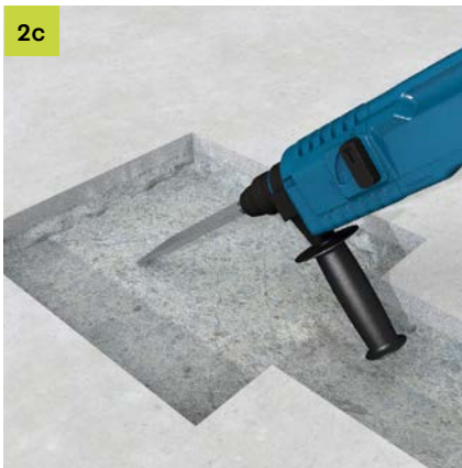
2c Unebenheiten mit einer Handfräse oder einem Stemmhammer ausbessern. Entsorgung von Bauschutt muss sach- und fachgerecht erfolgen.
