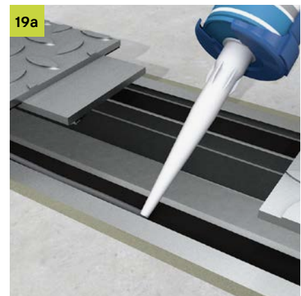
19a Zum Schutz vor Wasser und Schmutz (IP65), muss Dichtungsmasse am Rand auf die Auflagefläche der Schwerlastkanaldeckel aufgebracht werden.
