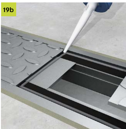
19b Dichtungsmasse zwischen Kanaldeckel und Kanaldeckel aufbringen.
