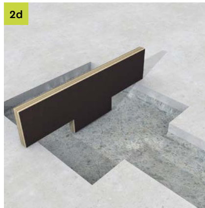
2d Optional hilft ein Tiefenprüfer (45 mm Prüfung, siehe Abbildung), um unebene Stellen in der Fräszzone leicht zu identifizieren.
