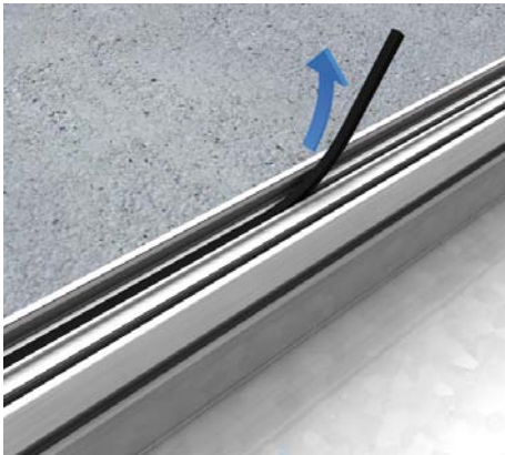
37 | Kanalsystem für nass gepflegte Linoleum-Belege Zunächst den Einlegegummi (UEBSPGD) aus dem Seitenprofil des Kanals vollständig entfernen.
