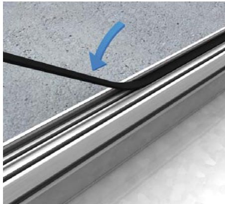
38 | Kanalsystem für nass gepflegte Linoleum-Belege Dann den Dichtungsgummi (UGDB15-R300 1.8) auf dem Seitenprofil in Längsrichtung vollflächig im gesamten Kanal verkleben.
