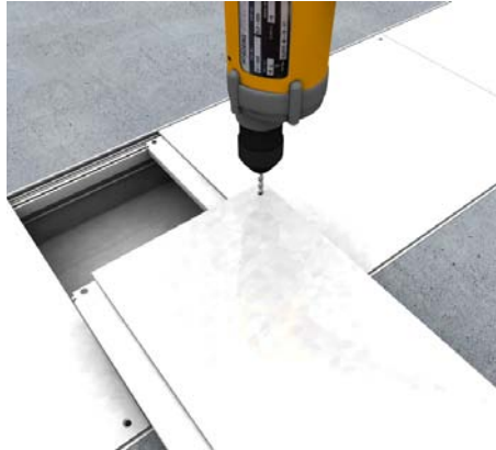
35 | Blinddeckelabschnitt Zusätzliche Bohrlöcher erstellen und dieses nachsenken.
