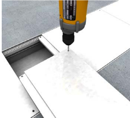
35 | Blinddeckelabschnitt Zusätzliche Bohrlöcher erstellen und diese nachsenken.
