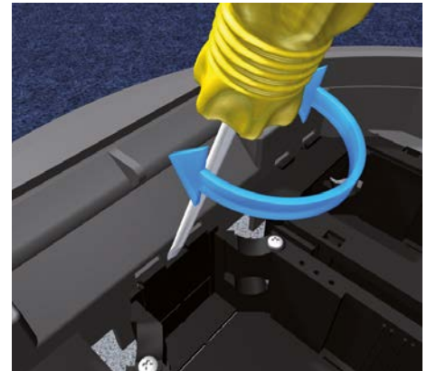
12 | Gerätebecher lösen Schraubendreher oder Montagehebel zwischen Rahmen und Gerätebecher einstecken. Rastnasen einzeln seitlich lösen und Gerätebecher entnehmen.
