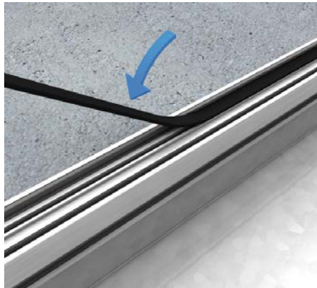
38 | Kanalsystem für nass gepflegte Linoleum-Belege Den Dichtungsgummi (UGDB15-R300 1.8) auf dem Seitenprofil in Längsrichtung vollflächig im gesamten Kanal verkleben.
