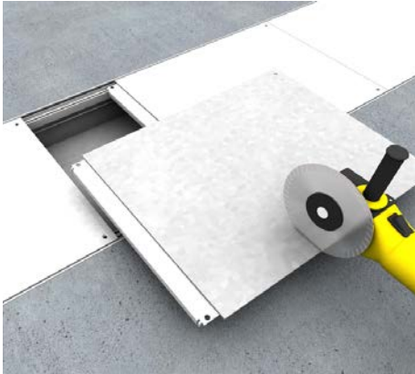
34 | Blinddeckelabschnitt Deckelabschnitt L < 500 mm auf die gewünschte Länge zuschneiden.
