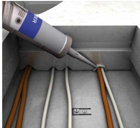
11 | Abdichten Abdichten aller Restöffnungen mit Silikon oder EasyFoam-Brandschutzschaum.
