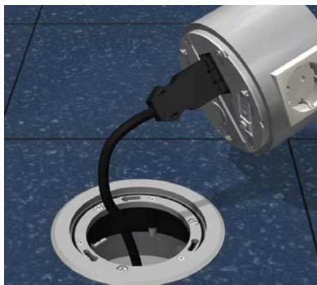
10 | Anschlussleitungen Das Buchsenteil der 3-poligen Verbindungsleitung an den Snap-In in der Bodenplatte einstecken.
