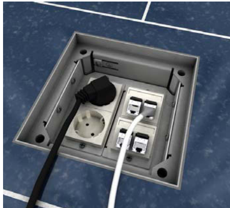
11 | Bestückung Stark- und Schwachstromtechnik einstecken.
