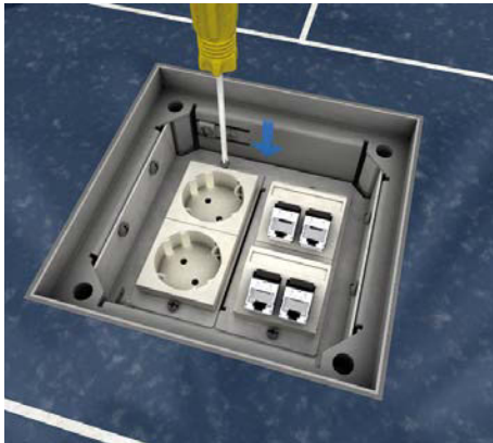
10 | Einzelauslassrahmen Bestückte Platinen am Einzelauslassrahmen verschrauben.
