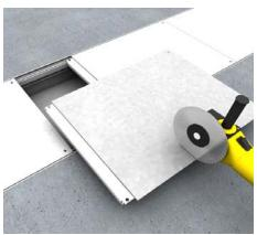
**34 | Blinddeckelabschnitt** Deckelabschnitt L< 500 mm auf die gewünschte Länge
