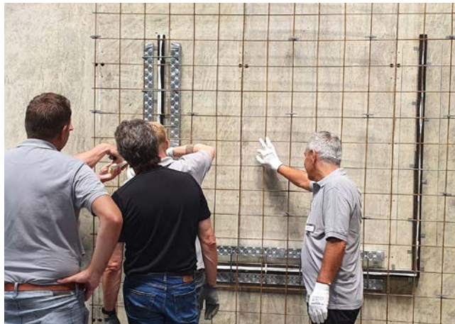
Der wasserundurchlässige Rückbiegeanschluss PENTAFLEX® Modul in der Entwicklung ...
