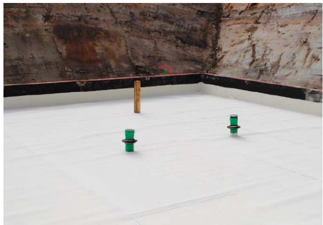
Das SECUFLEX® Frischbetonverbundsystem dient der flächigen Abdichtung als Zusatzmaßnahme.
