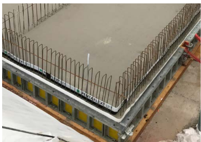
Das Fugenblech PENTAFLEX KB® nach der Betonage
