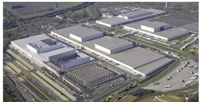
Befestigung auf dem Dach
