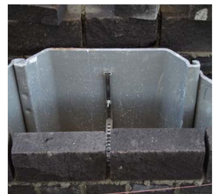
Anschluss von Verblendmauerwerk an Spundwand
