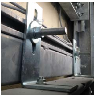
Befestigung von Aufzugstüren in einem Gitterträgerschacht
