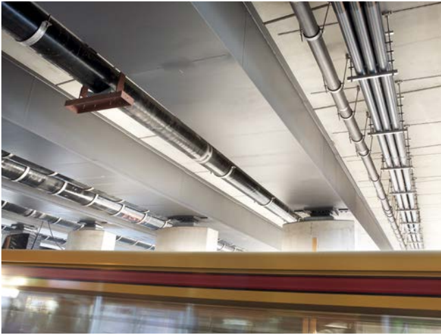
Spandauer-Damm-Brücke in Berlin, Deutschland
