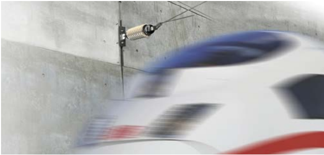
Oberleitung im Tunnel
