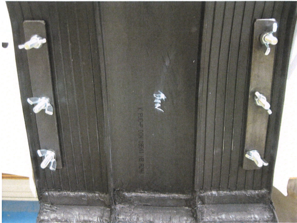
Bild A4: Fertige Verschraubung (wasserabgewandte Seite)
