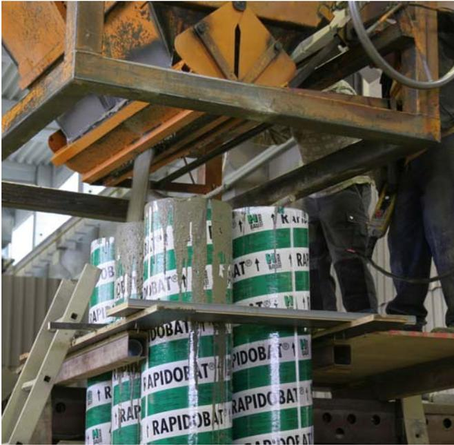
Abbildung 2: Befüllen der Stützen bei Betonage A.
