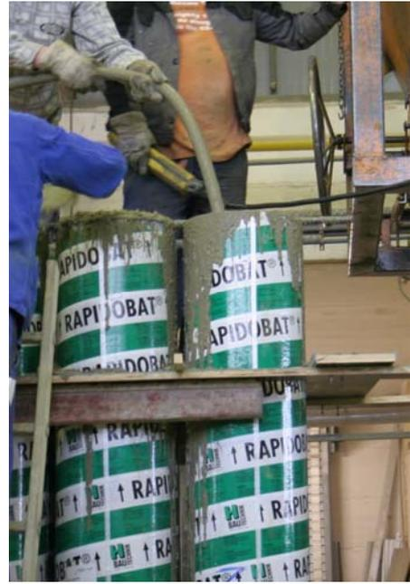
Abbildung 3: Verdichten des Betons mit einem Flaschenrüttler.
