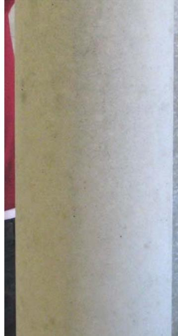
Abbildung 7: Stütze aus Schalrohr Rapidobat Cretcon HD.
