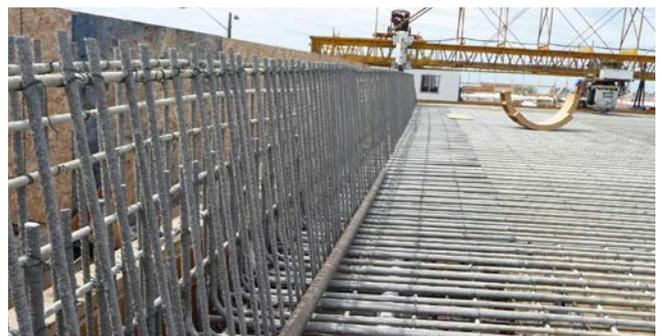
Einbau von FIBERNOX® V-ROD in Brückendeck und Betonleitplanken
