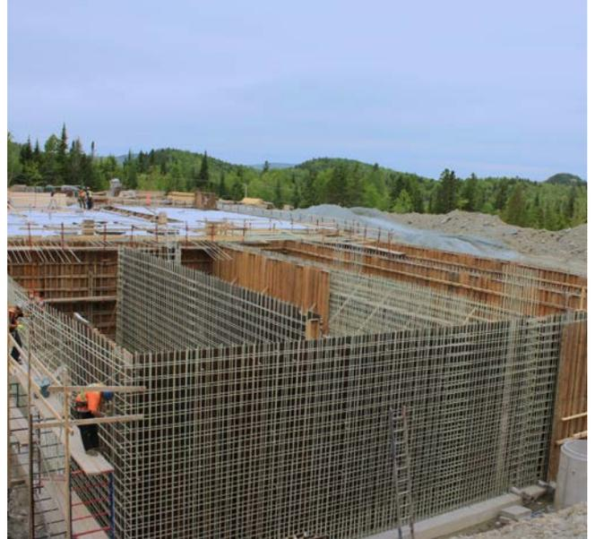
Tanks für Kläranlage, Wand- und Bodenplattenbewehrung
